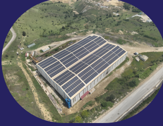
ÇAĞLAR MAKİNA 1.1MWp
